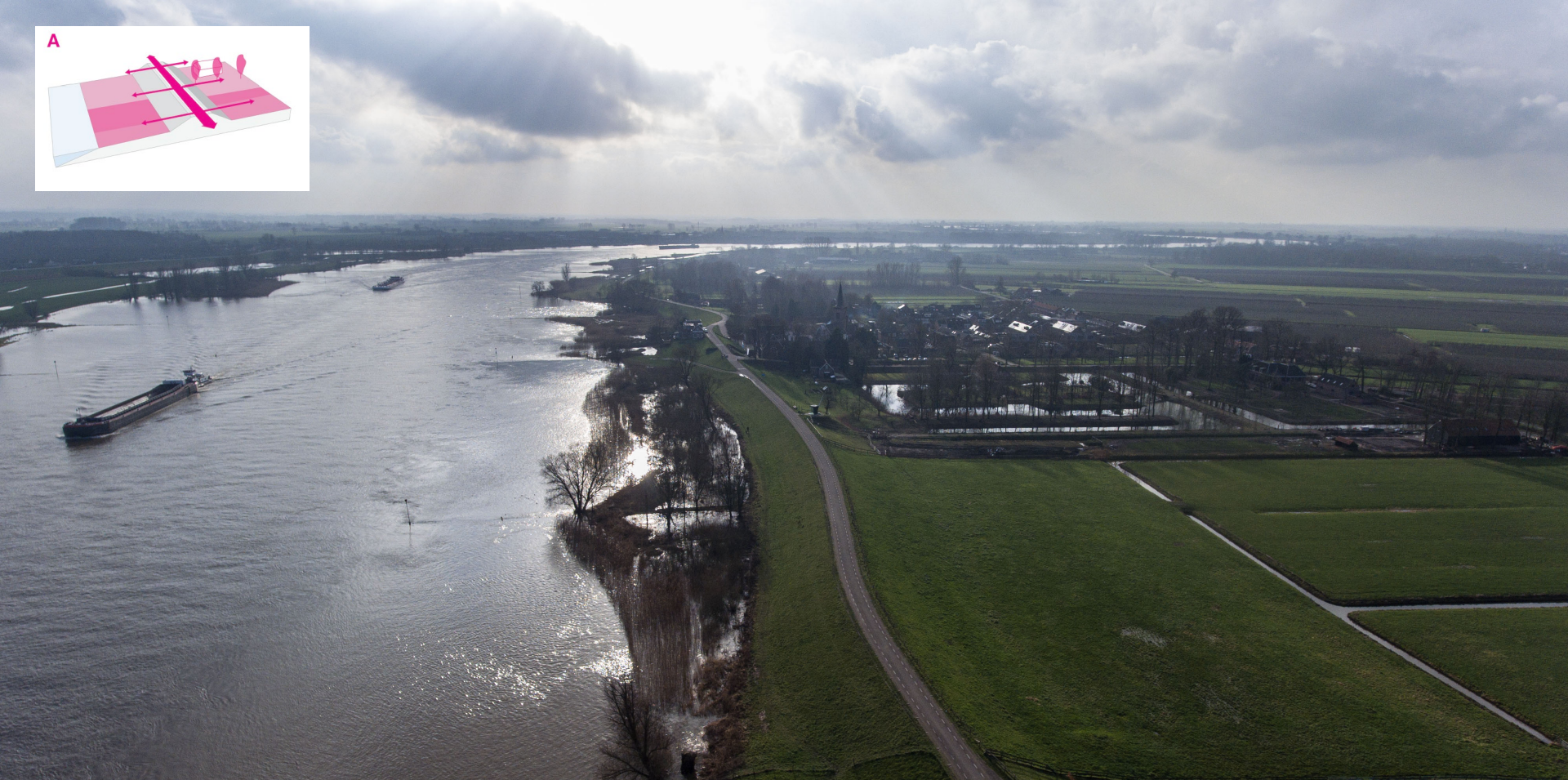
A. De dijk is een continu, verbindend element in het veranderende landschap (Zicht op Jaarsveld bij hoog water)
