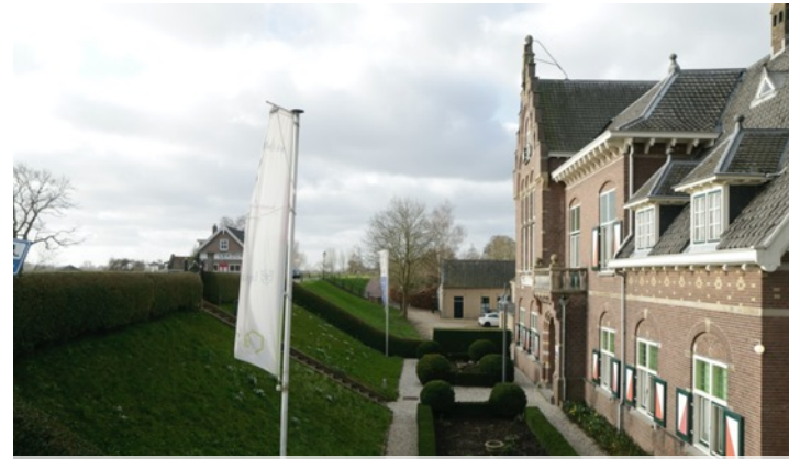
Bebouwing aan de dijk, Waterschapshuis Jaarsveld
