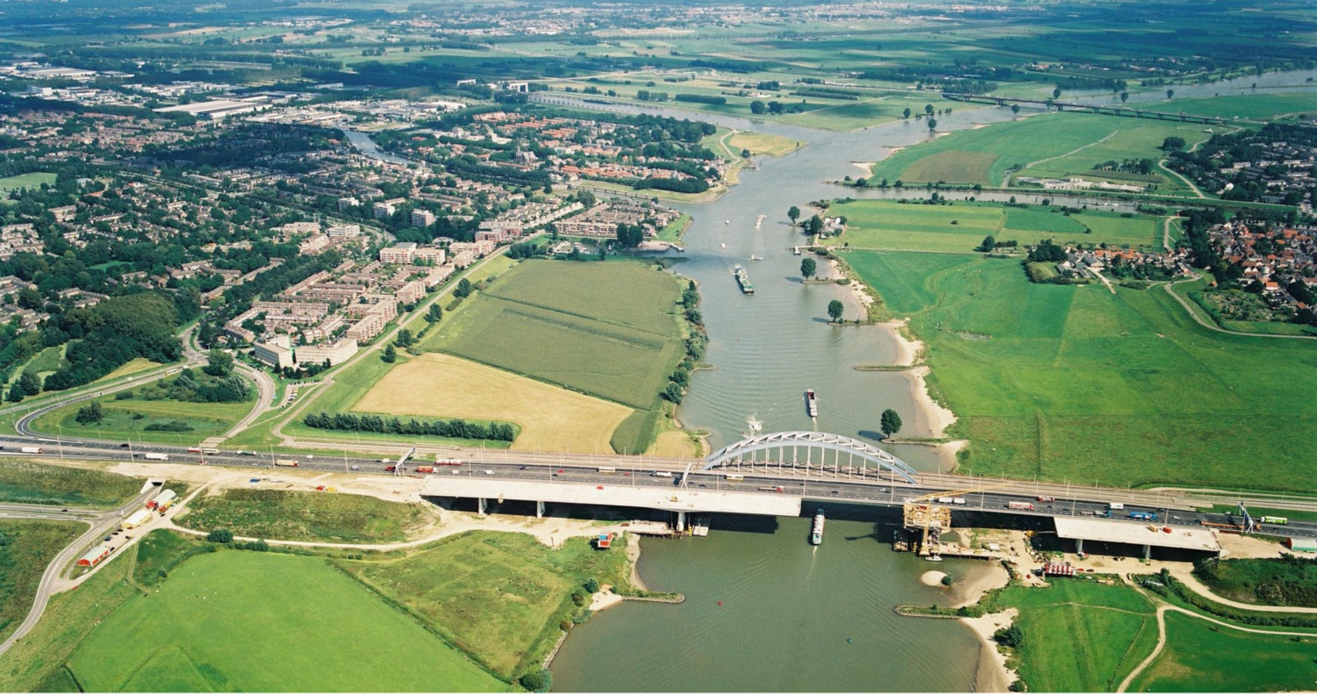
Bouw van de brug over de A2 bij Vreeswijk in 2002.
