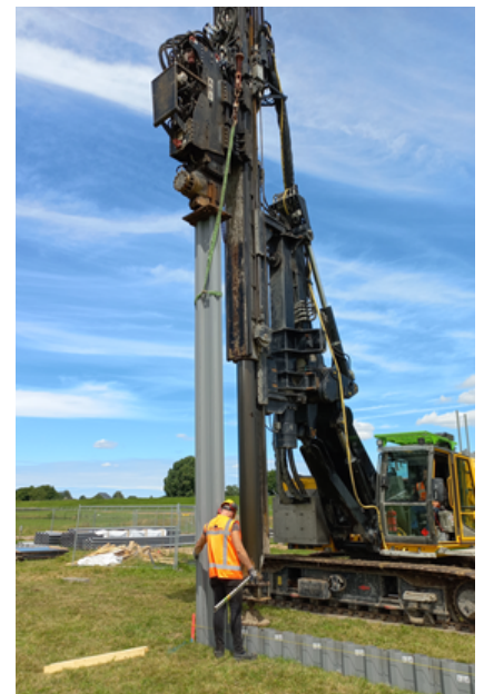
Foto 1: Stelling voor aanbrengen Prolock Filterscherm (Veldproef 2021)
