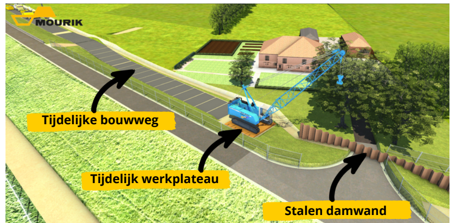
Afbeelding 2 - Impressie aanbrengen stalen damwanden in een oprit
