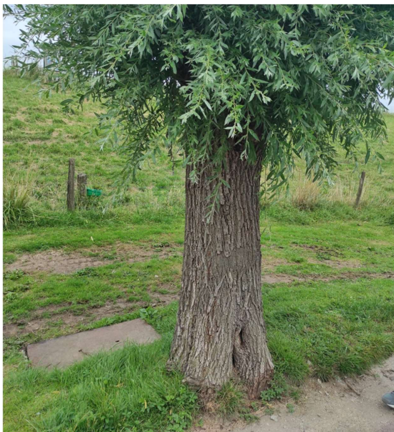
Boom 1391 is niet verplantbaar vanwege waterput en asfalt direct naast de boom.
