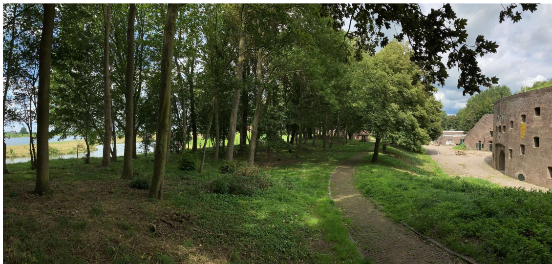
Figuur 2: foto van de locatie waar de fortwal niet voldoet aan de waterveiligheid (linkerzijde foto)
