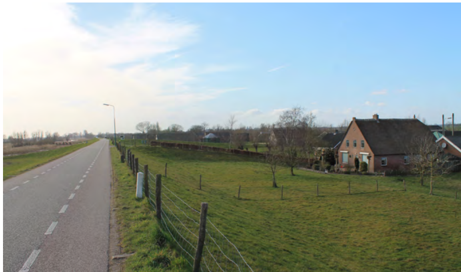
Haakse aansluiting op dijk
