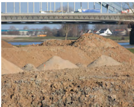
Zandwinning en geulaanleg bij de Bossenwaard
