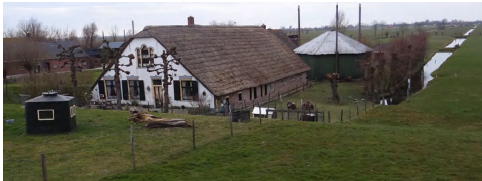
Bebouwing achter de dijk
