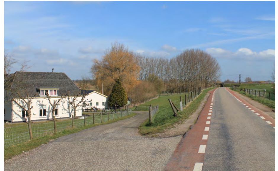
Zij-aansluiting op de dijk
