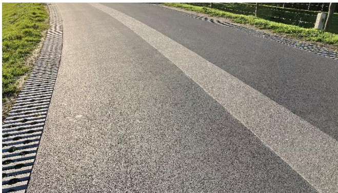
Figuur 1: Proefvak 1 met doorlopende coating van de rijloper
