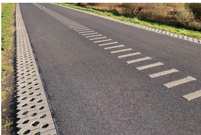
Figuur 3: Proefvak 2 met onderbroken (ribbel) coating van de rijloper
