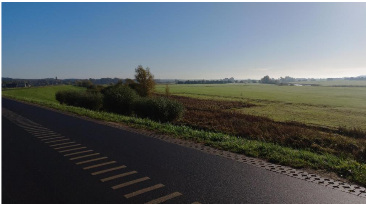
Figuur 3-2. Proefvak ribbelmarkering en berm
