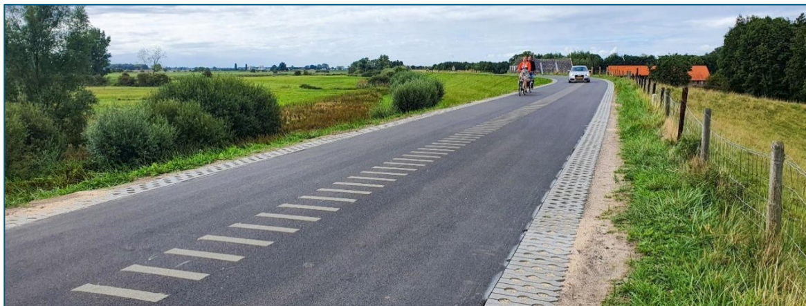
Figuur 1-4. Variant 2 Onderbroken variant, zogenaamde ribbelvariant
