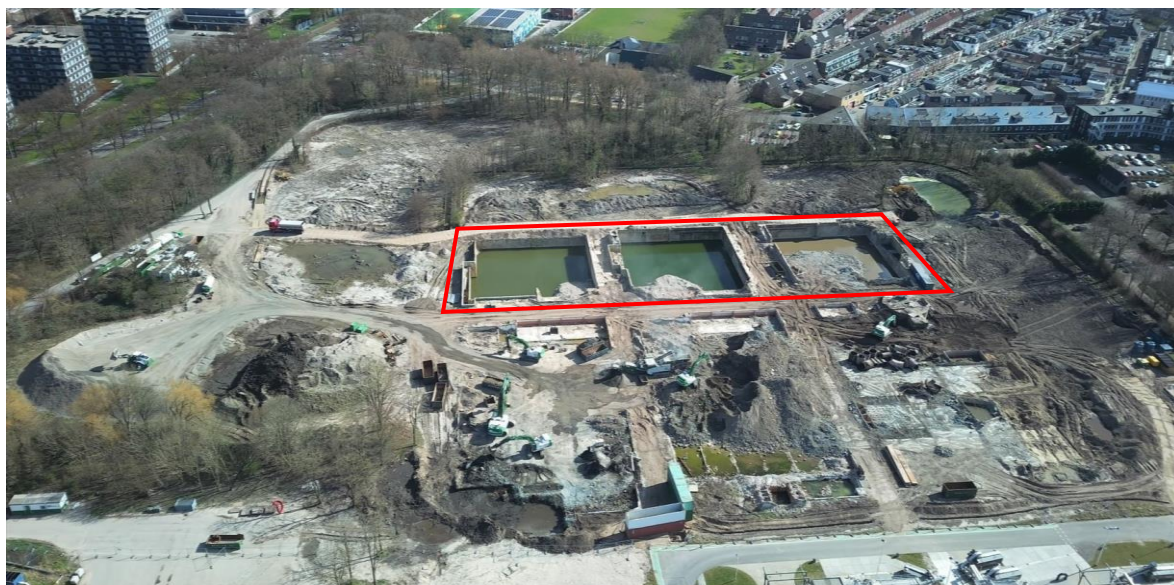
Een luchtfoto van de situatie in maart. Rood omkaderd de te slopen beluchtingstanks (mei-juni).
