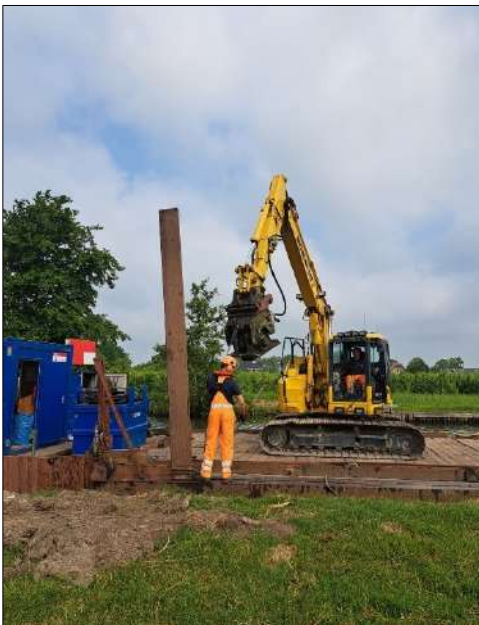
Werk in uitvoering bij het plaatsen van houten damwanden langs de Hollandse IJssel (bron: HDSR).
