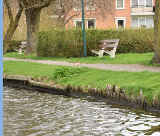
Opknappen oevers Montfoort: Tussen de Waterpoort en de Jan Hoenlaan wordt de beschoeiing vervangen
