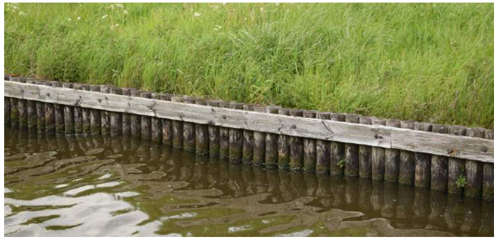
Figuur 3.10.5 - 4. Houten beschoeiing met perkoenpalen Harde oever
