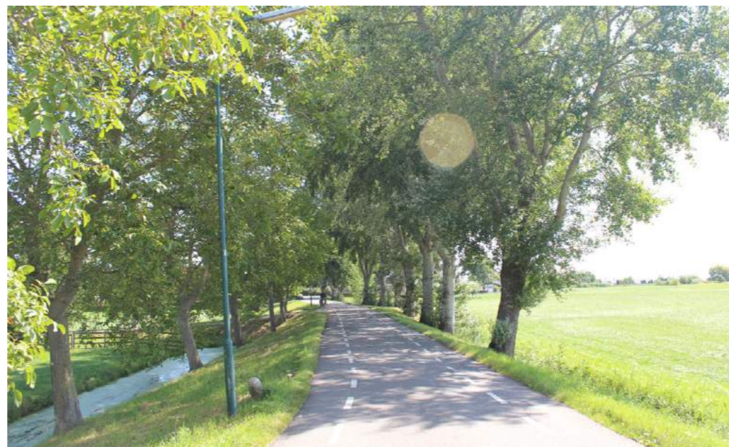
Figuur 3.6.8 - Waterkering met bomen op het talud (walnoot, populier), waterkering ligt hoger t.o.v. het omliggende landschap
