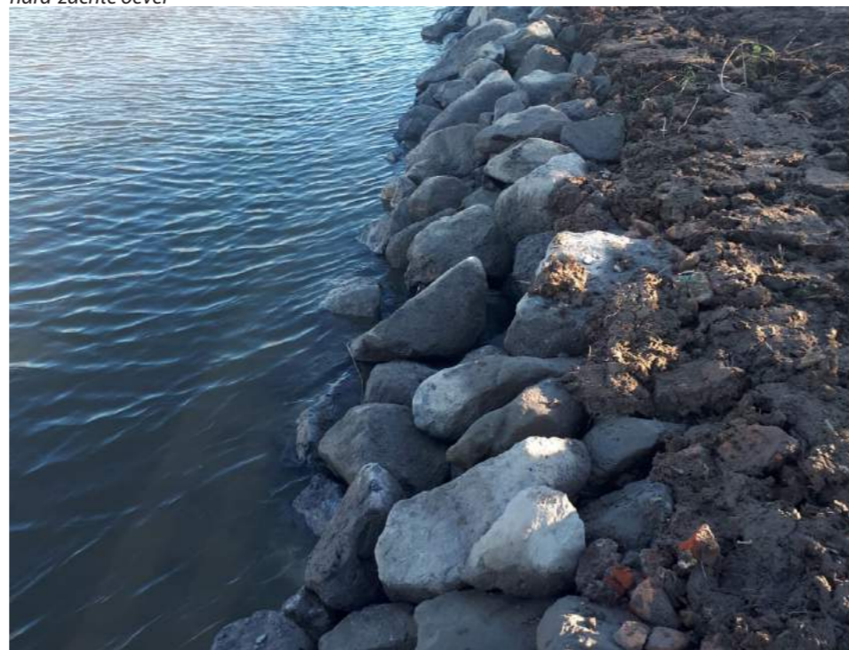
Figuur 3.10.11 - 5. Onderwaterbeschoeiing met steenbestorting harde oever
