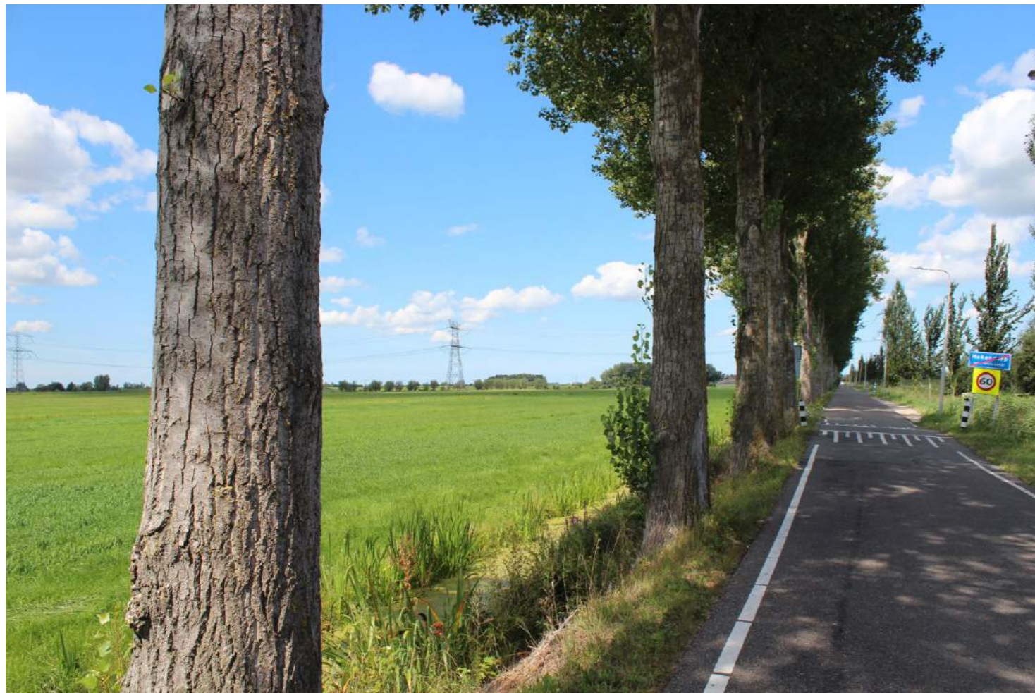
Figuur 4.3 - Bomen op de waterkering kan een knelpunt zijn voor de waterveiligheid
