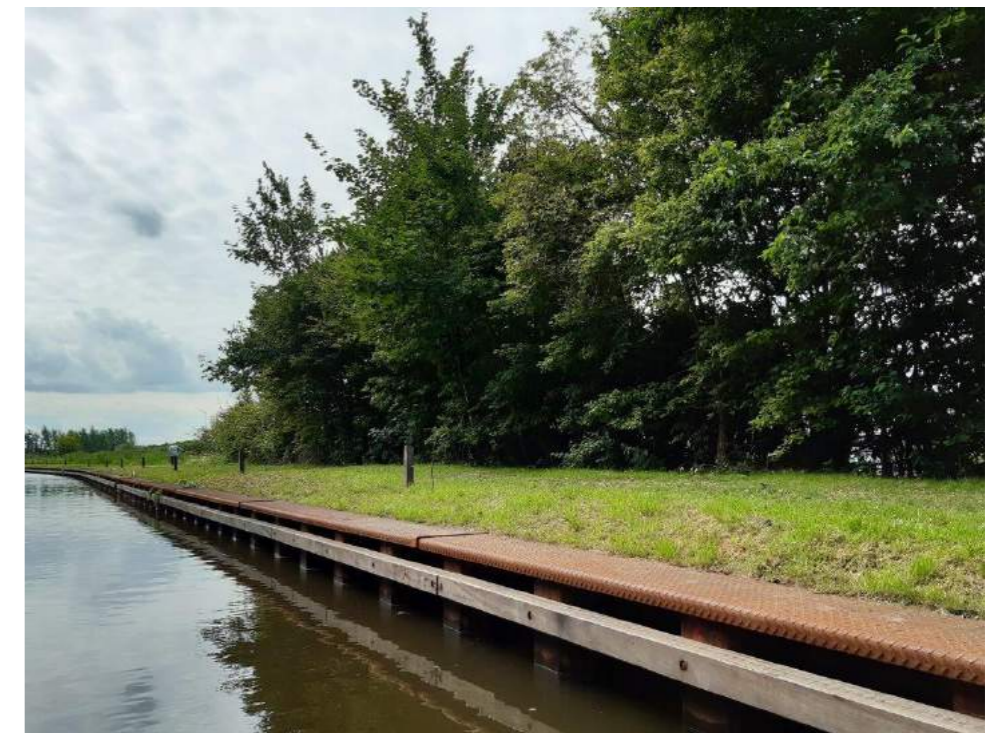
Figuur 3.10.4 - 3. Stalen damwand met houten gording (Stormkade Oudewater) harde oever
