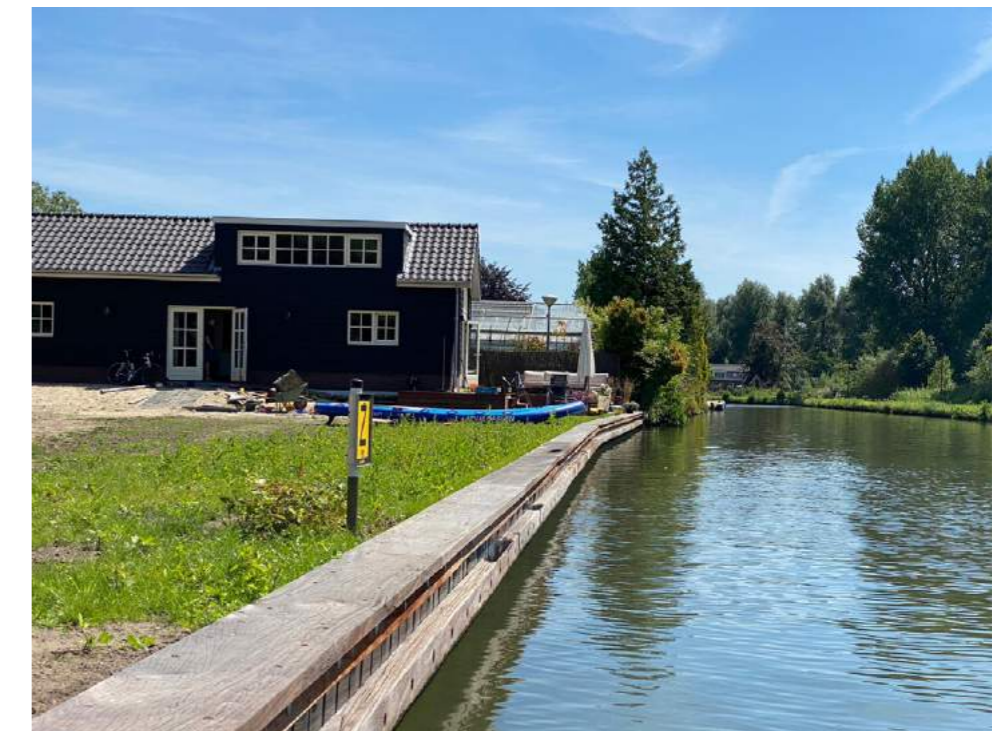
Figuur 3.10.10 - 6. Prolock beschoeiing met houten gording en deksloof harde oever
