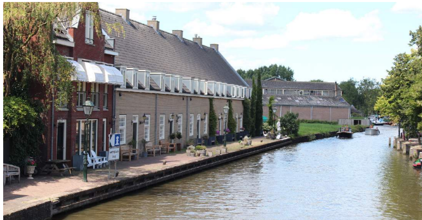
Figuur 3.11.7 - Kade in Oudewater
