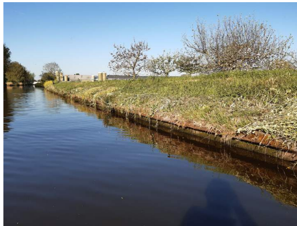
Figuur 3.10.2 - 1. Houten beschoeiing met daarachter het talud van de voorlandkering harde oever
