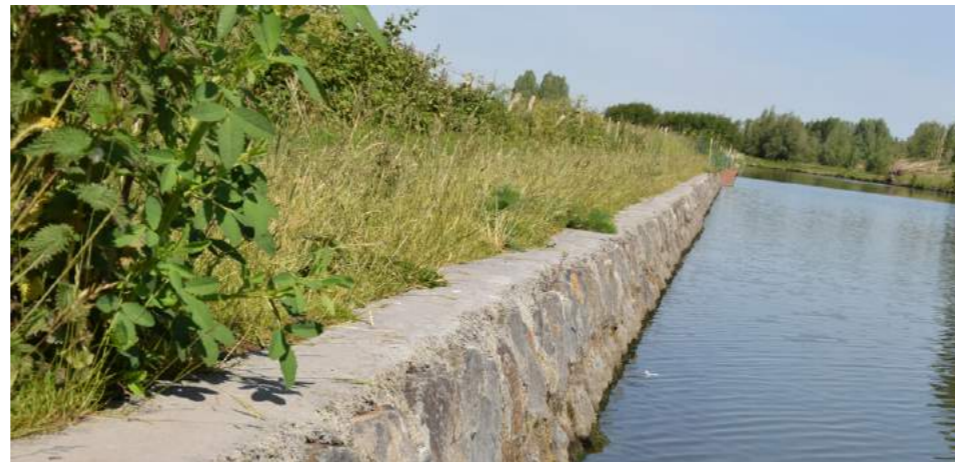
Figuur 3.10.6 - 5. Basalten oever op stalen damwand (pilot IJsselstein) Harde oever
