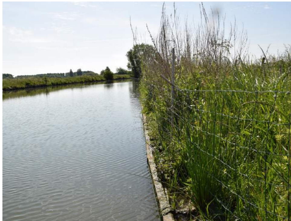
Figuur 3.10.7 - 5. Lage houten beschoeiing (pilot IJsselstein) hard-zachte oever
