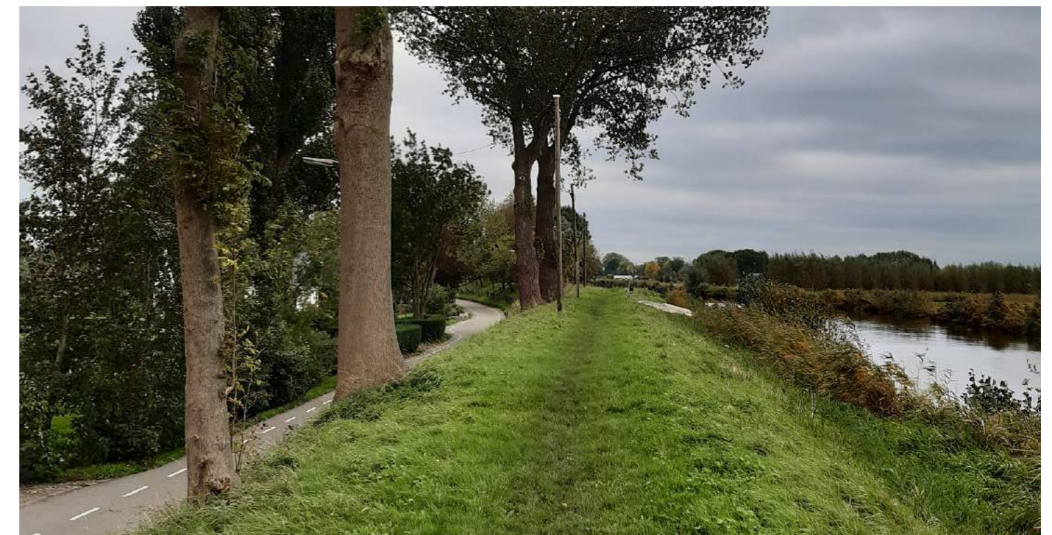
Figuur 3.11.12 - Kade in Oudewater
