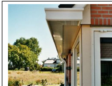
Fig. 2 glasvezelversterkte polyester dakgoot (GVP)
