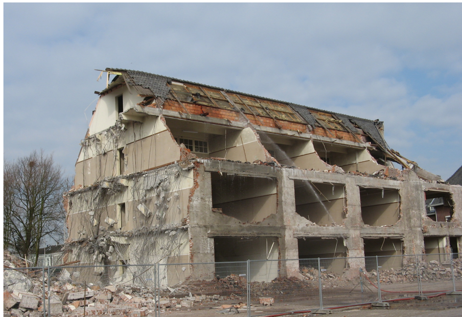
Afbeelding 11: Gestript gebouw, eerst is het buitenblad verwijderd. Hierdoor krijgen aanwezig vleermuizen de kans om te ontsnappen.
