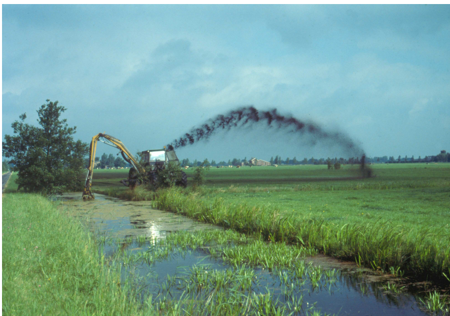
Afbeelding 4: Baggerpomp aan het werk in watergang met krabbescheer.
