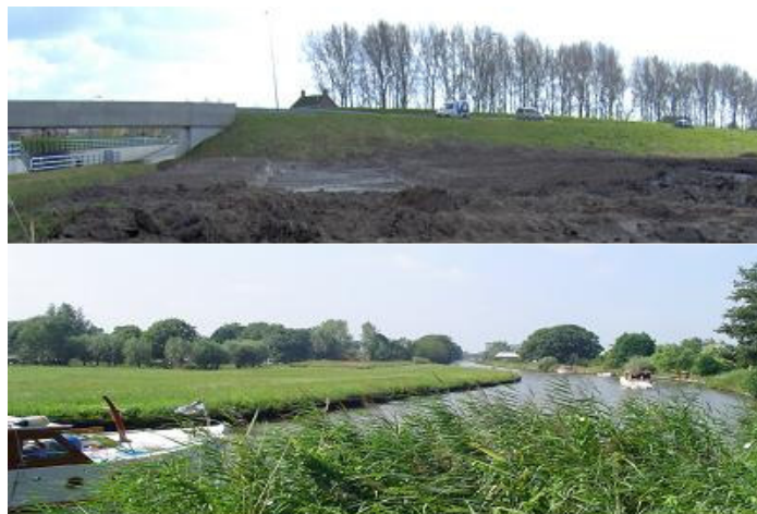
Foto's: aanleg helofytenfilter Zenderpark en pleziervaart op de Hollandse IJssel
