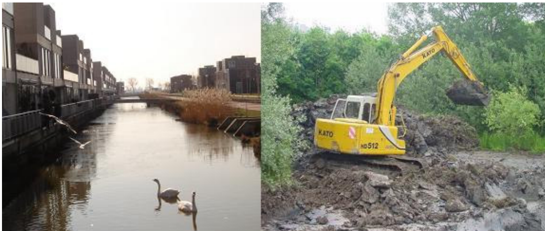
Foto's: watergang in Zenderpark, graaf werkzaamheden aanleg paddenpoel
