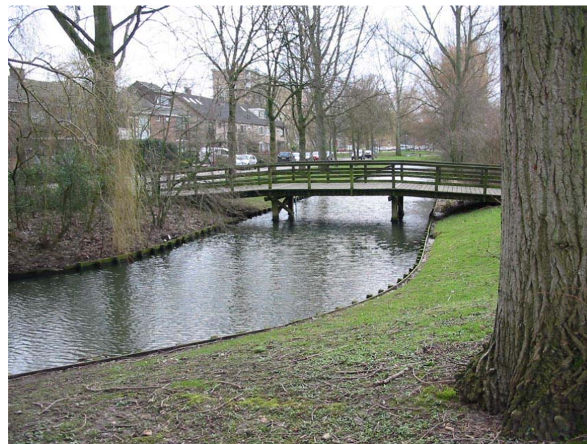
afbeelding 8.1. Bruggetje over watergang aan de Breitnerlaan
