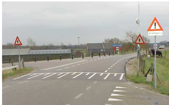
Figuur 6 Infrastructuur op waterkering
