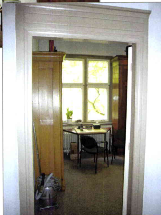
Toegangsdeur tot bovengenoemde ruimte. De deuren en deurkozijnen bevinden zich nog in authentieke staat met originele profilering.
