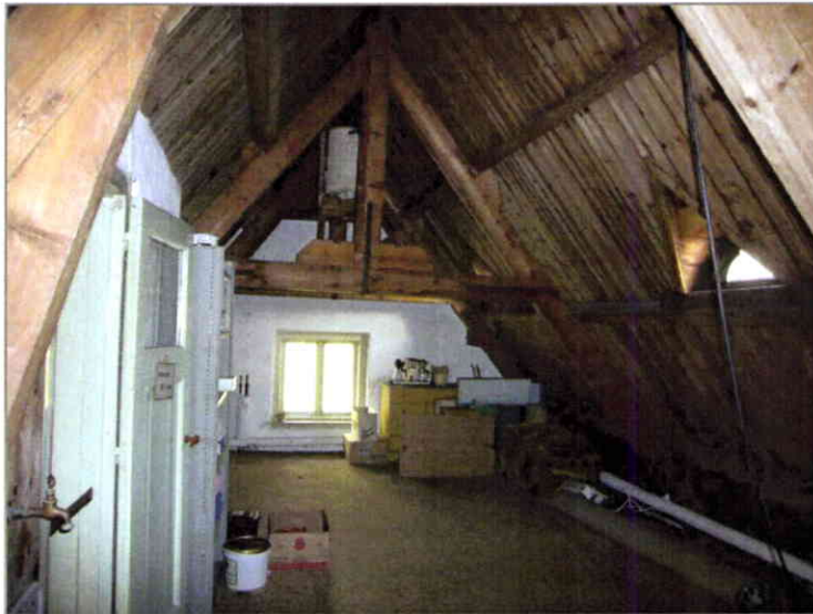
Het lagere zoldergedeelte met zadeldak.
