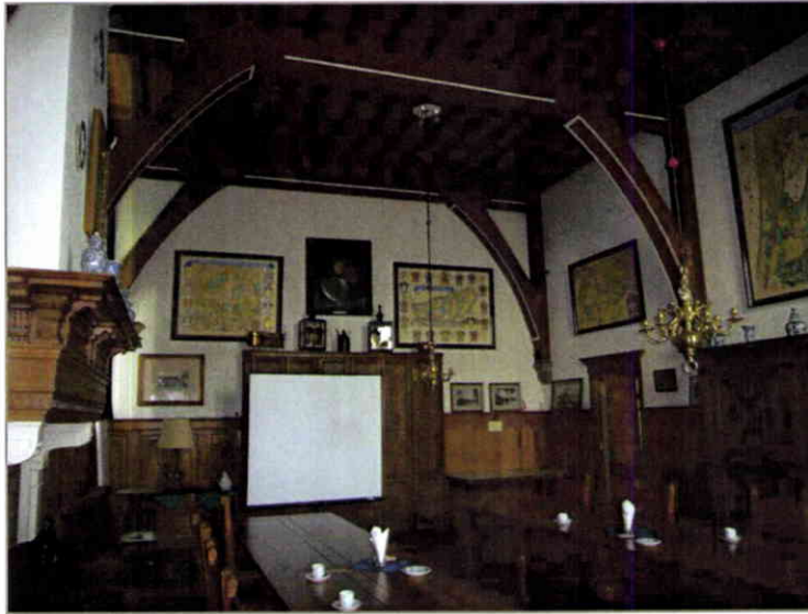
De grote zaal ofwel de 'vergaderzaal' op de verdieping. De rijk uitgevoerde zaal is voorzien van een gesteld moer- en kinderbintenplafond op grote korbelen. Links op de foto is de schouw te zien. De ruimte is voorzien van houten lambrisering. Rechts op de foto de doorgang naar de overloop.
