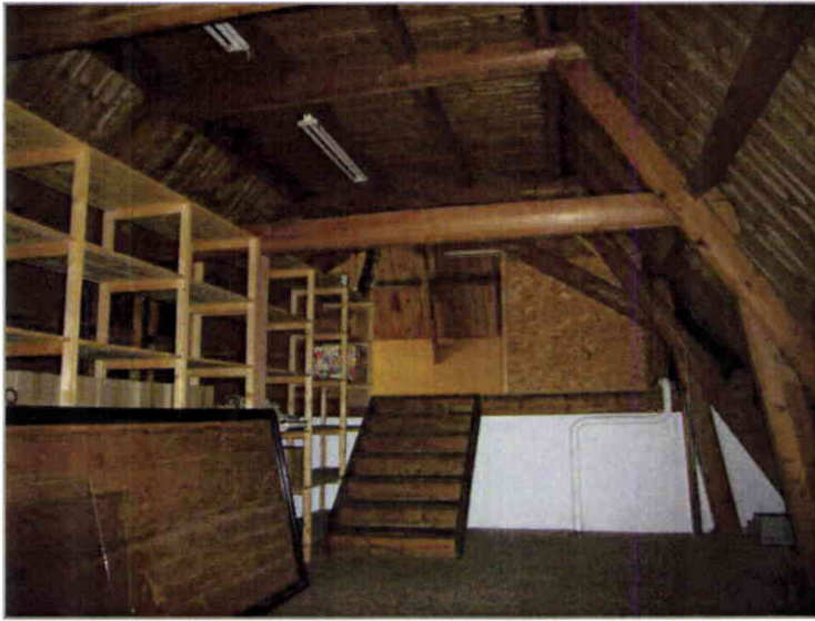
Zolderverdieping met zicht op de kapconstructie van de gordingenkap met staand schot. Op de foto is ook de hoogde vloer te zien waaronder de hoge vergaderzaal.
