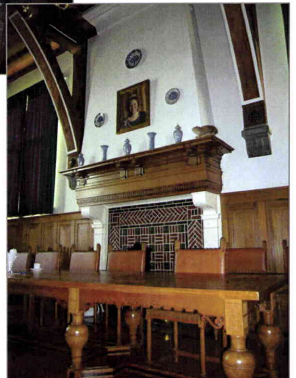
Schouw ter hoogte van de westelijke kopgevel van het Polderhuis. De schouw is uitgevoerd met een eikenhouten lijst, natuurstenen consoles en siermetaalwerk in de haardnis.
