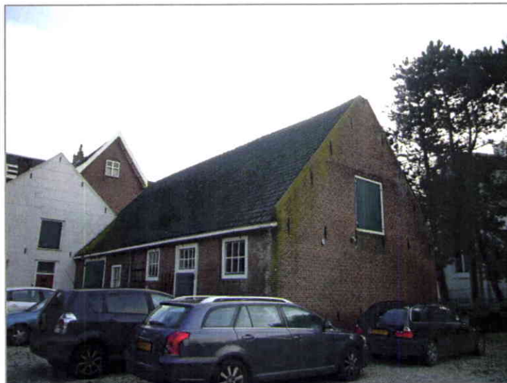
De meest noord-westelijke schuur gelegen op het achterterrein. Het metselwerk van deze schuur laat zien dat het gebouw van ouder datum is dan het hoofdgebouw. Het vlechtwerk van de topgevel en de sobere indeling van gevelopeningen typeren het bouwvolume.
